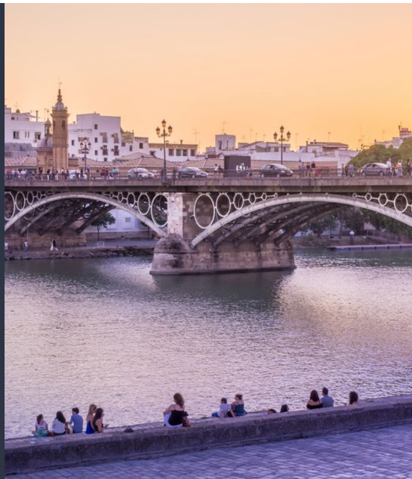
▲ PUENTE DE ISABEL II
